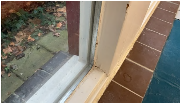
Afb. 5 – Open verbindingen houten kozijnen zwemzaal
