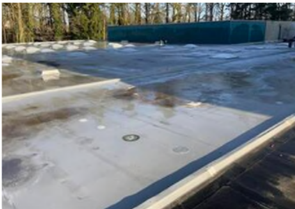
Afb. 7 – Overzicht pvc dakafwerking
