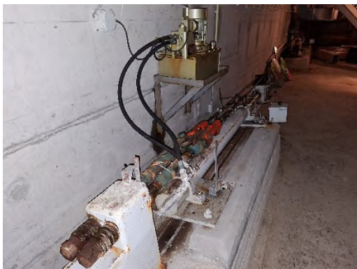
Afb. 15 – Bedieningsmechanisme beweegbare bodem
