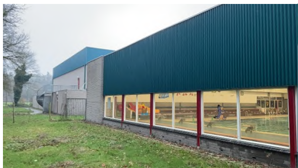
Afb. 3 – Gevelafwerking damwandprofiel
