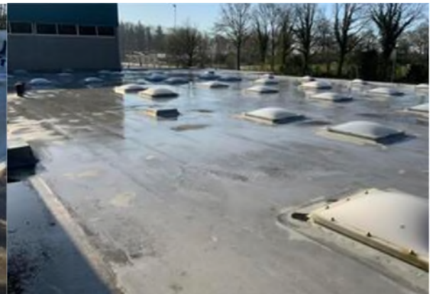
Afb. 8 – Overzicht pvc dakafwerking
