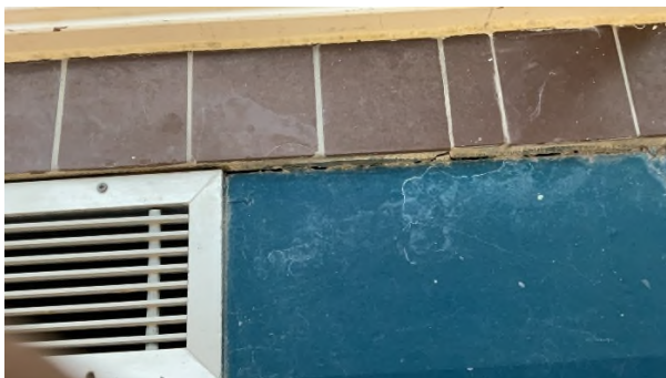
Afb. 9 – Tegelwerk achter zitbanken in zwemzaal
